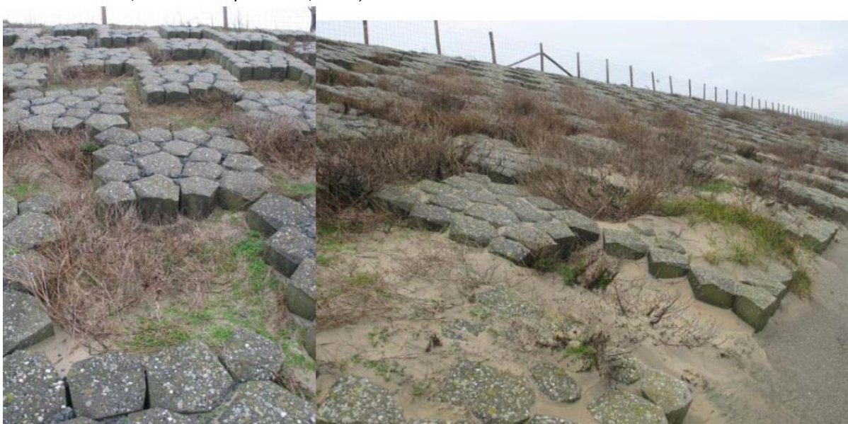
Figuur 5 Verstuivingsgradiënt met weinig overstuiving aan de bovenkant (links) en snel toenemend naar onder toe (rechts) ter hoogte van transect 2 (december 2015).
