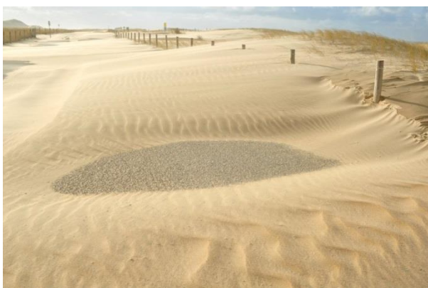
Figuur 14 Ondergestoven fietspad in de Hondsbossche Duinen (foto: HHNK)
