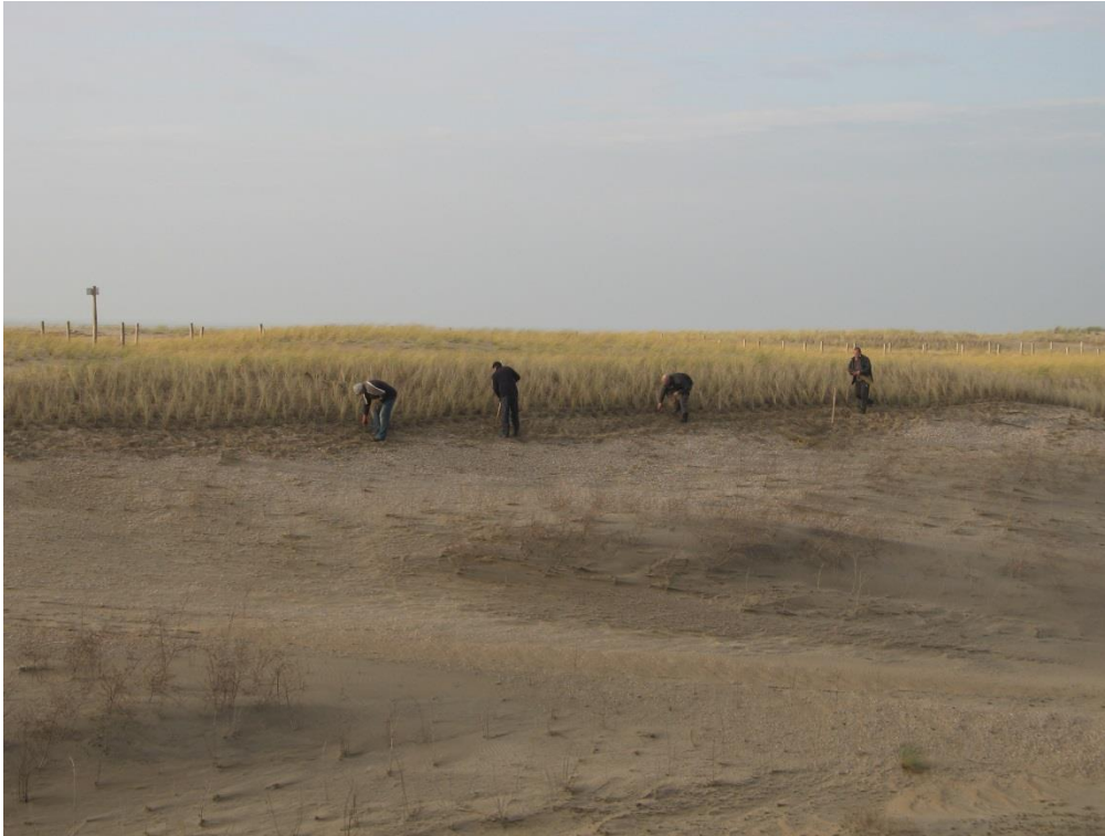
Foto 1. Helmplanters planten een strook Helm in boven de struweelaanplant.
