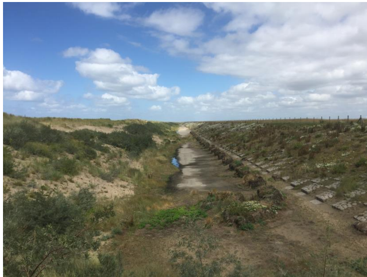
Figuur 2. Locatie bij T1 met de stobalen aan de oude dijkzijde: sterke uitbreiding van ruigteplanten rond deze stobalen (die het zaad van deze planten meebrachten). Aan de linkerzijde valt de zeer wisselende aanslag van de geplante struiken op (zie ook fig. 3).
