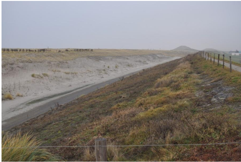
Fig. 12. Oude dijk (rechts) en lijkzijde van het hoge duin (links) nabij T5. De dijk is aan het verruigen. Het verschil in staat van de beplanting in dit noordelijke deel van het werk met het zuidelijke deel is groot: dezelfde “patchiness” bestaat, maar het geheel is veel minder ver ontwikkeld dan in het zuiden. Er lijkt ook meer erosie op te treden dan in het zuiden.
