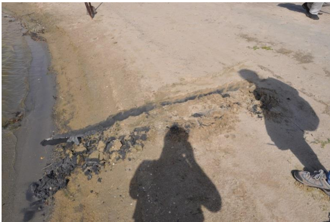
Figuur 9. Gedeeltelijke dwarsdoorsnede door het dammetje in de vallei: gereduceerd sediment en afgestorven struiken door zout indringing.
