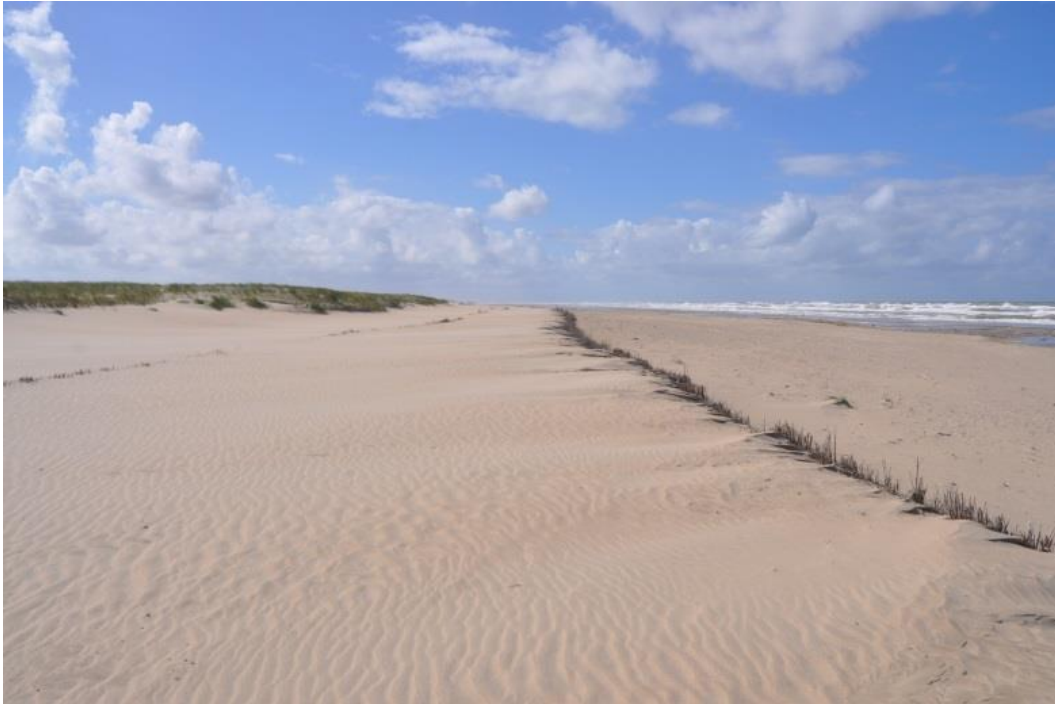
Figuur 10. Schermen van wilgentenen tot het maximum benut. Al het alsnog aankomende zand vliegt door.
