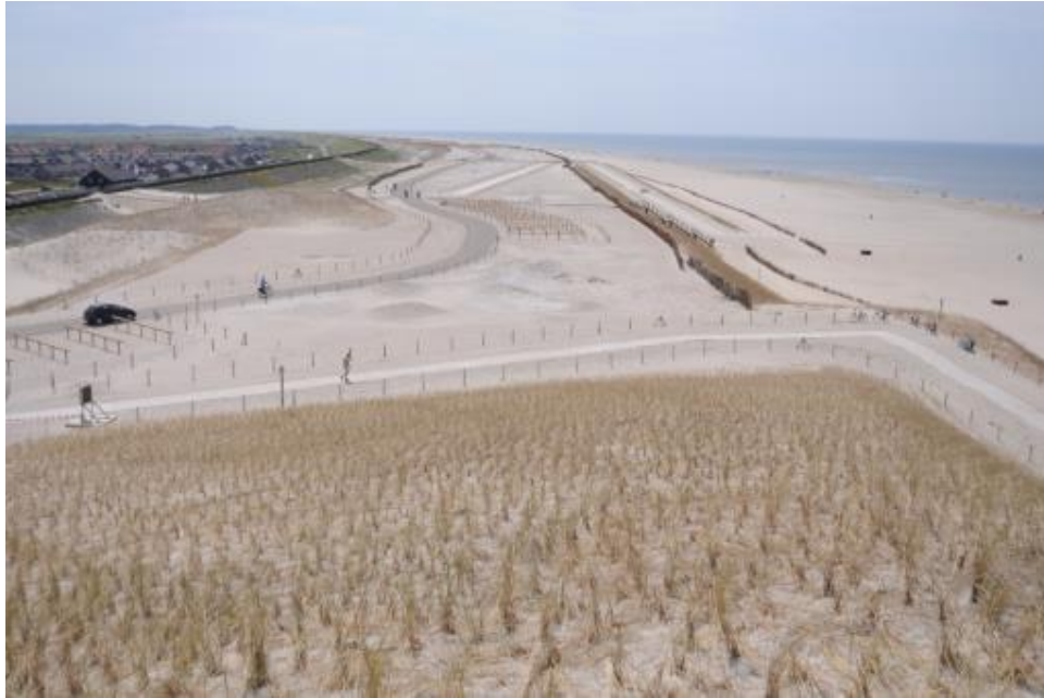
Fig. 12. Overzichtsfoto van de noordelijke aansluiting van KHPZ op HPZ 1. Dit deel van het werk is onlangs gereedgekomen en aan de inrichting wordt nog gewerkt. De witte tinten van de papierpulp zijn nog aanwezig en er beweegt nog maar heel weinig zand.
