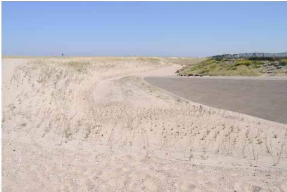
Fig. 2. Zuidelijke aansluiting van KHPZ op HPZ. Let op de aan de basis uitlopende struiken en de rijk begroeide oude dijkhelling met daar bovenop het stuifscherm en aan de basis de nog zichtbare asfalt bekleding. Het lage, grijzige deel midden op de foto is van een locale, dunne kleibestrooiing voorzien. Foto L. van der Valk.
