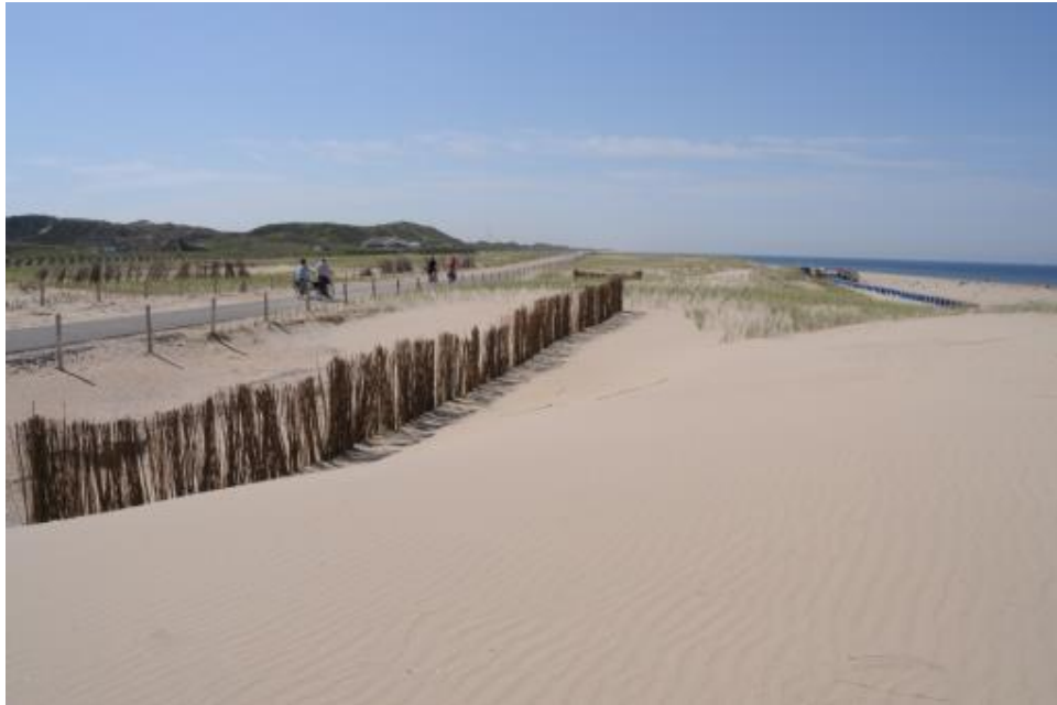
Fig. 5 “Luwe Laagte” met relatief veel inzanding, welke door een wilgentenen-scherm beteugeld moet worden. Rechts: naar schatting meer dan 1 m opzanding; links: het talud van het fietspad wordt licht ondergraven door uitblazing. Op de achtergrond rechts is de rij blauwe strandhuisjes nog zichtbaar.
