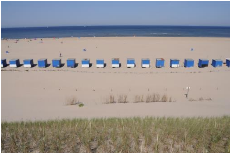
Fig. 4. Omkleedhuisjes voor de KHPZ. Deze configuratie van huisjes (formaat, constructie (op palen), tussenruimtes (relatief groot) lijkt bijna transparant voor stuifzand, getuige de eenvormige ontwikkeling achter de huisjes.
