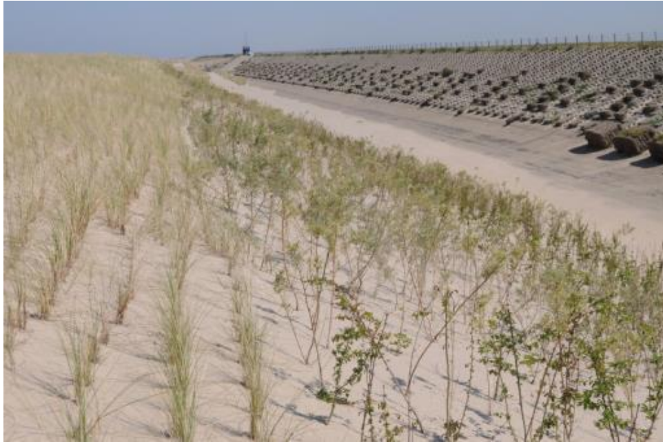
Fig. 6. De achterzijde van KHPZ en de voorzijde van HPZ. Let op het vele groen aan de pas geplante struiken en de leegheid (van ingewaaid zand) tussen de steenbekleding. De strobalen liggen er verloren bij.
