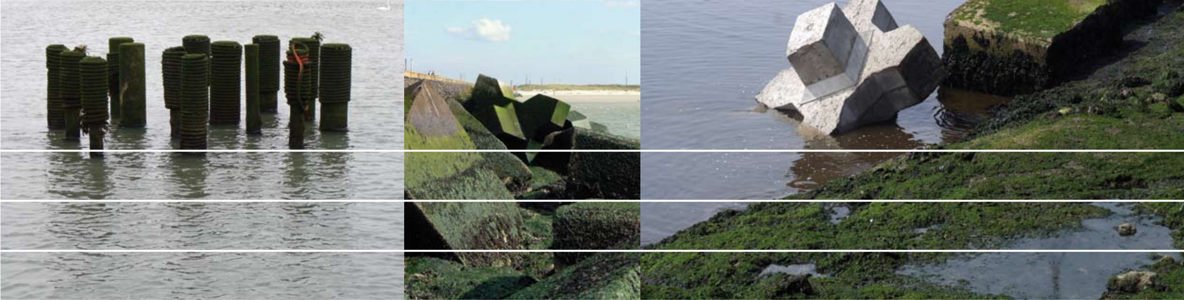
Palenbos – beschutte dijk op diep water In de Nieuwe waterweg staat de allereerste pilot van het Rijke Dijk project; een klein palenbos. Een palenbos breekt de golven en zorgt voor bezinking van sediment, daarnaast biedt het aanhechtingsmogelijkheden voor wieren en mosselen. Het palenbos is neergezet in 2007 en bestaat uit houten en betonnen palen die in het zand zijn geslagen, omwikkeld met verschillende soorten touw.
