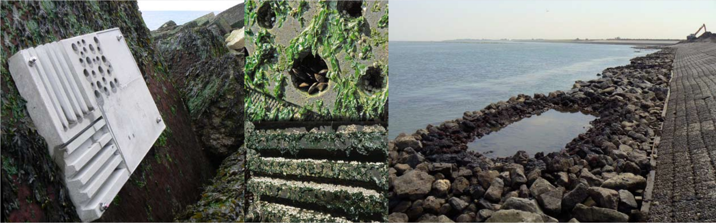
IJmuiden Ecobeton – geëxponeerde dijk op diep water In samenwerking met Rijkswaterstaat Zuid Holland, Microbeton, Shell, C-fix B.V. en BAM Infraconsult is een pilot gestart op de havenpier van IJmuiden. In april 2008 zijn op bestaande betonblokken tegels geplaatst van verschillende materialen en met verschillende structuren (kuilen, gaten en richels).
