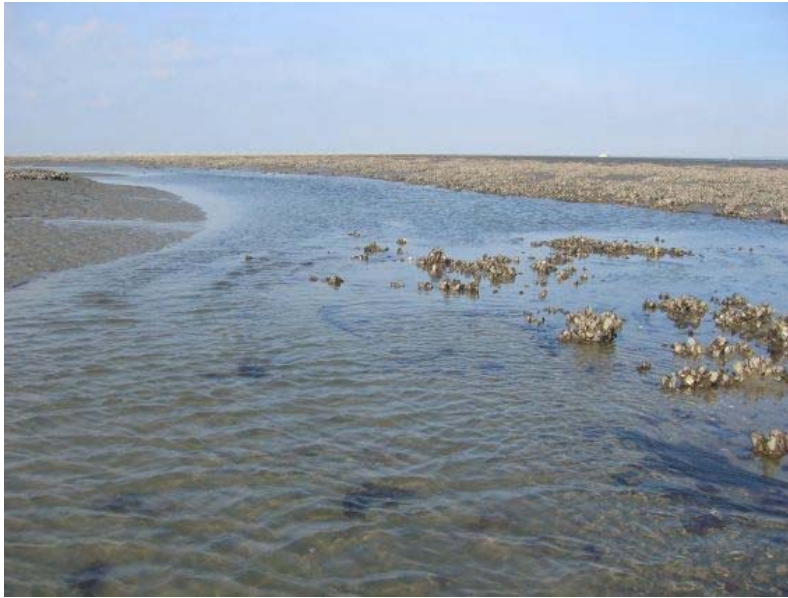
Figuur 2. Geul waarin het bezinkbasin van de suppletie afwatert (foto: G. Ramaekers).
