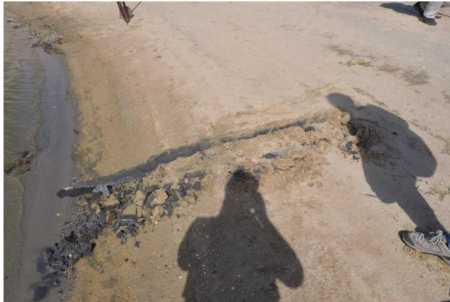
Fig 4. Gedeeltelijke dwarsdoorsnede door het dammetje in de vallei: gereduceerd sediment en afgestorven struiken door zout indringing.
