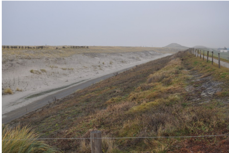
Fig. 12. Oude dijk (rechts) en lijzijde van het hoge duin (links) nabij T5. De dijk is aan het verruigen. Het verschil in staat van de beplanting in dit noordelijke deel van het werk met het zuidelijke deel is groot: dezelfde “patchiness” bestaat, maar het geheel is veel minder ver ontwikkeld dan in het zuiden. Er lijkt ook meer erosie op te treden dan in het zuiden.
