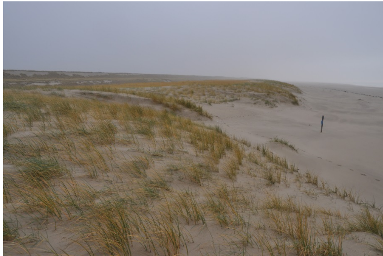
Fig. 10 Voorzijde van het lage duin bij T3 in zuidelijke richting. Het opbreken van het strakke helmfront (= zeewaartse beplantingsgrens) en de verwildering van het plantpatroon is zichtbaar. Er vormt zich een ondiepe kerf in de nieuwe zeereep. Zand wordt daar doorheen getransporteerd tot midden op het lage duin. Op het hoge strand is nog net een wilgenscherm zichtbaar.
