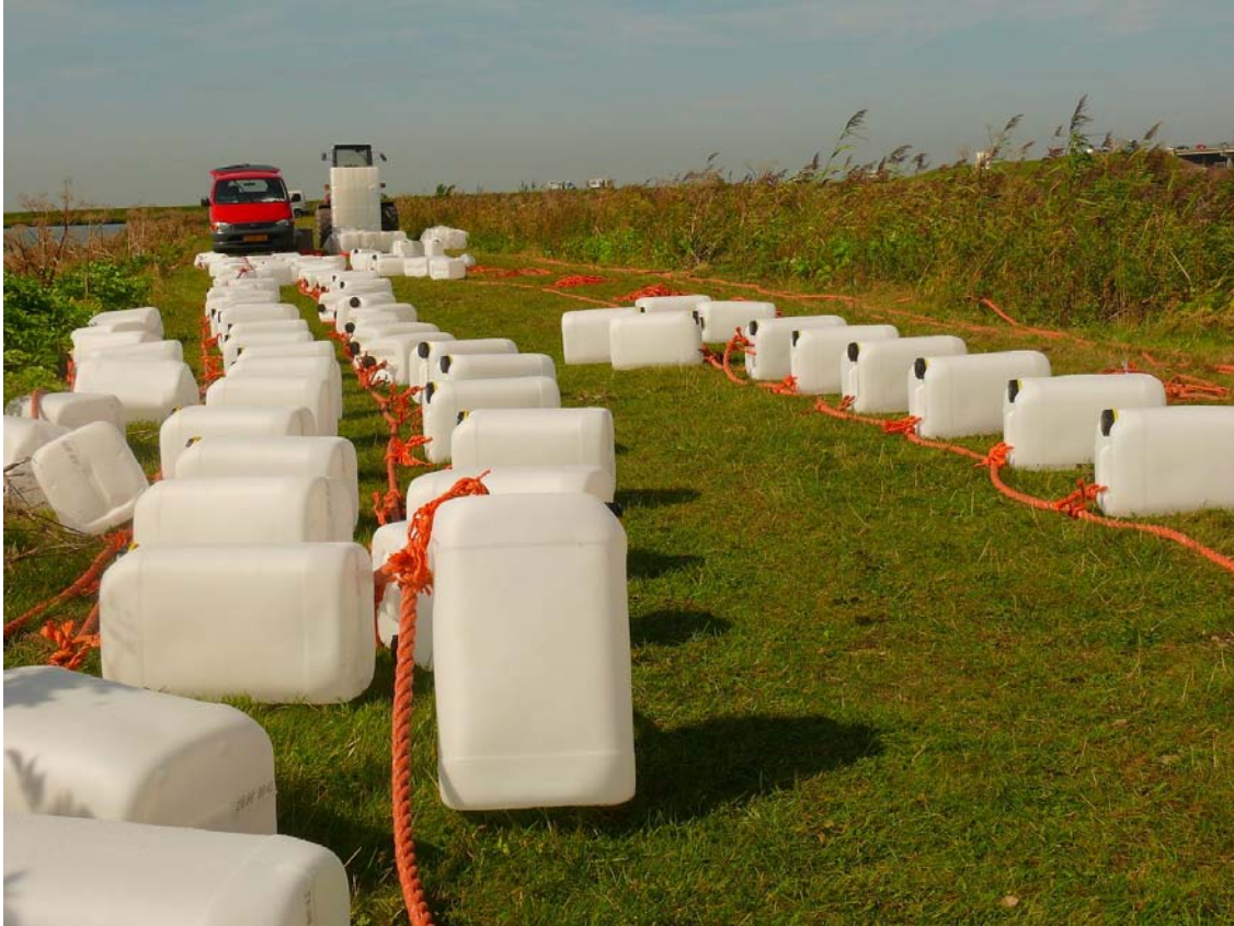
Figuur 5.3. Door middel van het plaatsen van plastic jerrycans onder de rijsmat is het drijfvermogen van de rijsmat vergroot. Deze jerrycans zijn door duikers onder de rijsmat aangebracht (Foto: G. van Geest)
