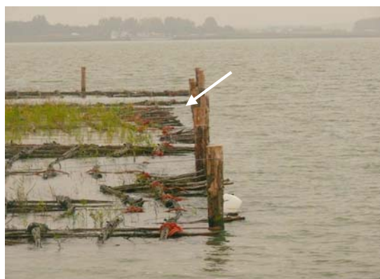
Figuur 5.5. Schade aan de mat als gevolg van de storm van 3 oktober. Op beide foto's is zichtbaar dat het tweede (middelste) en derde (achterste) deel van de rijsmat 'scheef' liggen (zie pijlen in figuur). Eveneens staan verschillende heipalen scheef (linkerfoto), wat waarschijnlijk het gevolg is van de druk die de storm op de heipalen heeft uitgeoefend (Foto's: G. van Geest)
