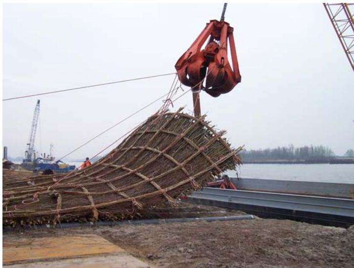
Figuur B-1: Verslepen van klassiek zinkstuk (foto uit Hamer den & Booster, 2008)
