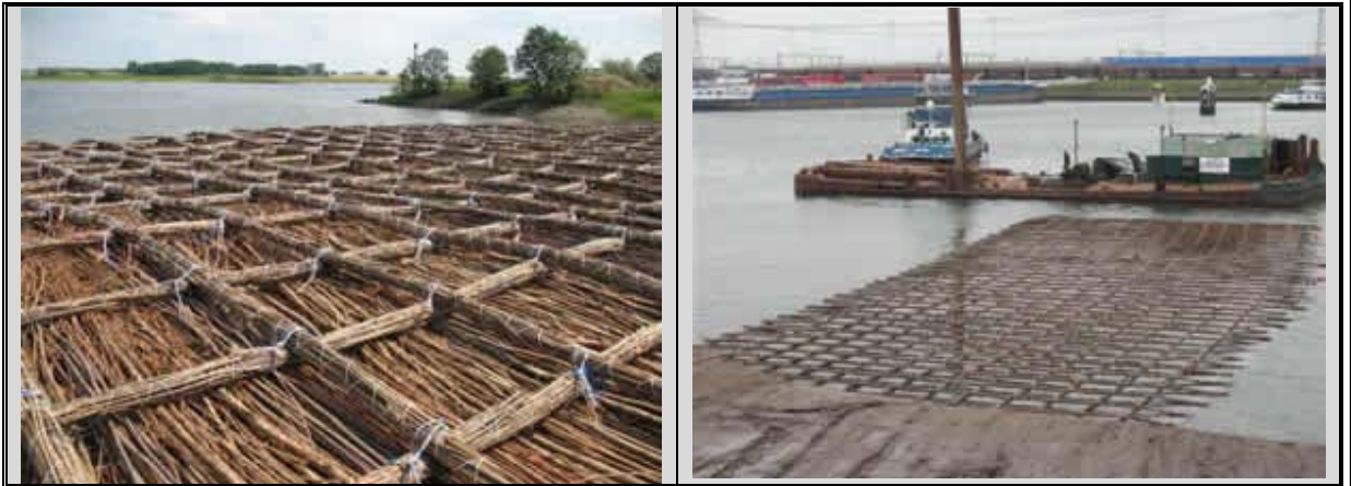
Figuur 2.2 Klassiek zinkstuk (matrix van wiepen gevuld met rijshout) (foto uit Hamer den & Booster, 2008)
