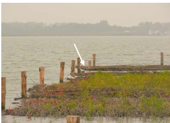
Figuur 5.5. Schade aan de mat als gevolg van de storm van 3 oktober. Op beide foto's is zichtbaar dat het tweede (middelste) en derde (achterste) deel van de rijsmat 'scheef' liggen (zie pijlen in figuur). Eveneens staan verschillende heipalen scheef (linkerfoto), wat waarschijnlijk het gevolg is van de druk die de storm op de heipalen heeft uitgeoefend (Foto's: G. van Geest)
