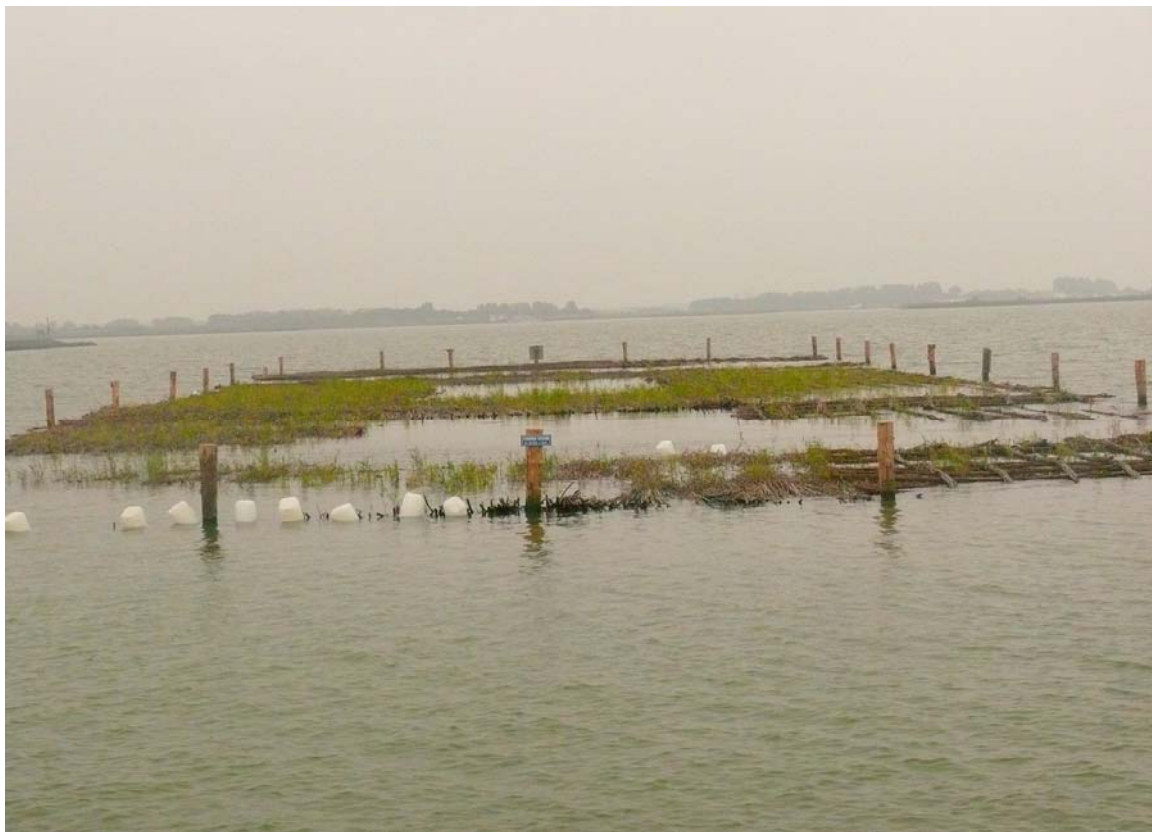
Figuur 5.4. Overzicht van de rijsmat na de storm van 3 oktober (foto: 6 oktober 2009). Op het eerste en derde deel van de rijsmat zijn waterplassen zichtbaar. (Foto: G. van Geest)
