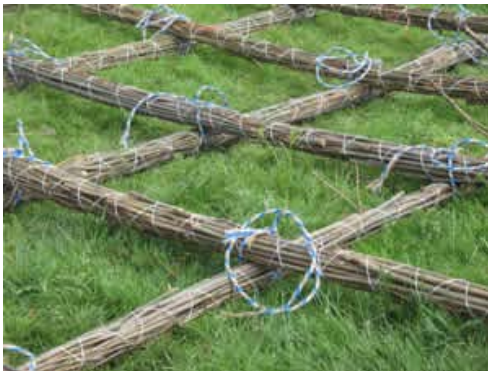
Figuur 2.1 Matrix van wiepen als basis voor een klassiek zinkstuk (foto uit Hamer den & Booster, 2008)
