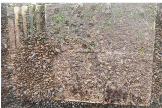
Figuur 4.1 Ecobetonplaat van de pier van IJmuiden. Linksonder op de foto het effect van horizontale gleuven, linksboven die van verticale gleuven.
